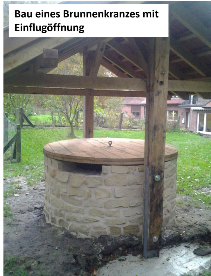
Bau eines Brunnenkranzes mit
